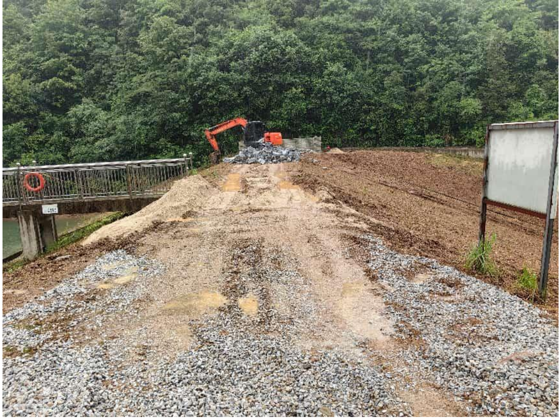
图 2 大坝（枢纽）加固全景照
