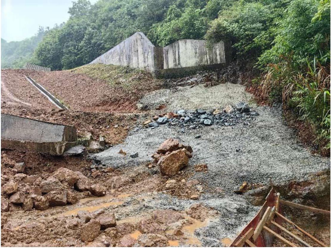
图 3 加固坡面全景照
