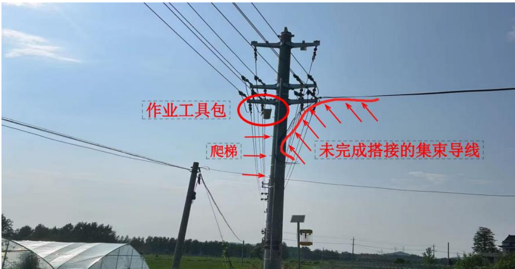
图 3. 事故电杆示意图
