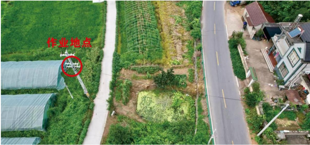
图 2. 事故电杆现场勘查图
