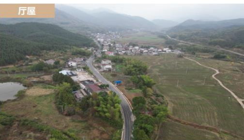
厅屋 —建筑以一层为主，住宅建筑材料多采用红砖为主，外立面白石灰抹缝处理，主色调采用白色、红色，屋顶多为坡屋顶，部分住宅建筑外墙裸露，3栋建筑质量较差。
