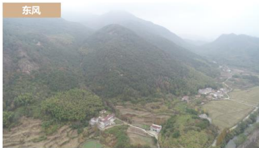
东风 —建筑以二层为主，住宅建筑材料多采用红砖为主，外立面白石灰抹缝处理，主色调采用白色、红色，屋顶多为坡屋顶以红色为主，部分住宅建筑外墙裸露，12栋建筑质量较差。
