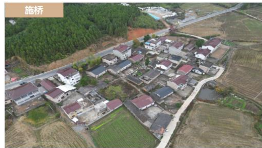
施桥 —建筑以一层为主，建筑材料多采用青砖、红砖为主，外立面白石灰抹缝处理，主色调采用白色、红色，屋顶为坡屋顶以红色和青色为主，部分住宅建筑外墙裸露，6栋建筑质量较差，村庄布局肌理沿道路布置。
