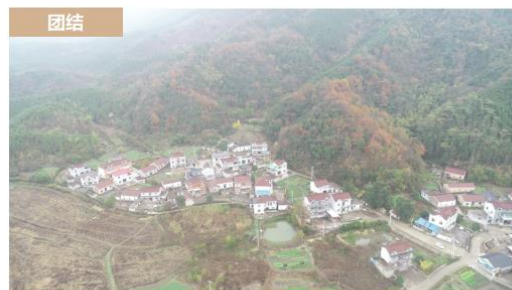
团结 —住宅建筑为二层为主，材质多采用红砖，主色调采用白色、红色，屋顶为坡屋顶，大部分住宅建筑质量较好，整体风貌统一，5栋建筑质量较差建筑。
