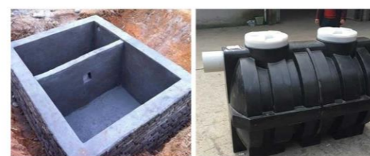
砖砌式化粪池
